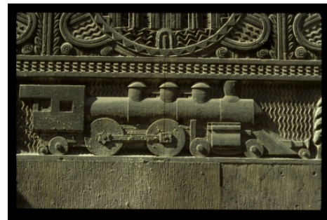
8. Detalj glavnog ulaza u Institut slepih u Budimpešti, arhitekta Bela Lajta, 1907.
